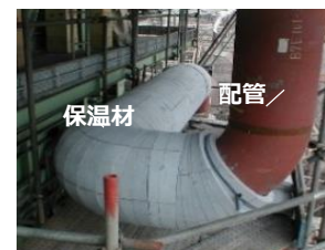
保温材取付け (施工中)
