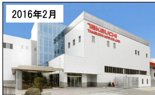
本社・第3工場 竣工（約30億円）
