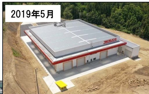
びんぐし試験棟 建設（約9億円）
