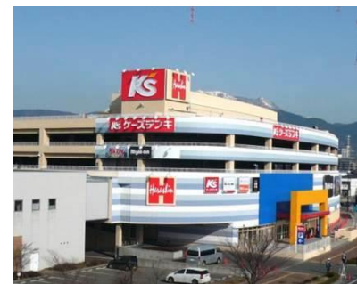
長野商業施設
