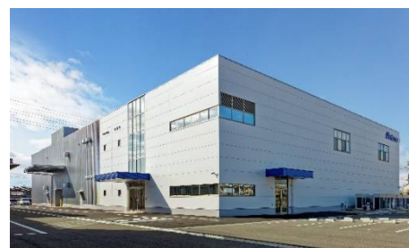
中部第二工場外観
