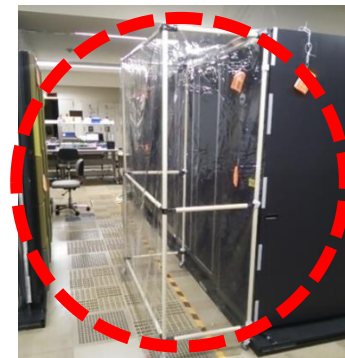
【施工例 (BOXタイプ)】
