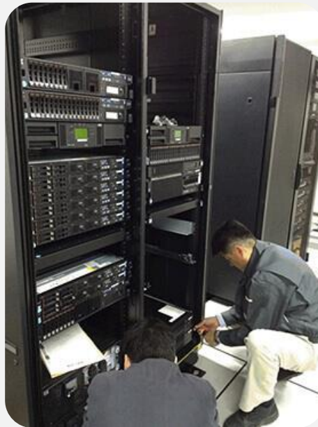
サーバー移設・配送・設置
