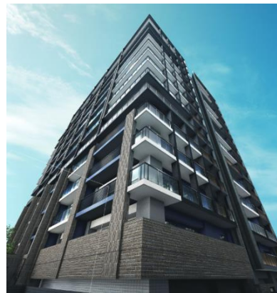
レーベン浦和常盤 THE TOWER
