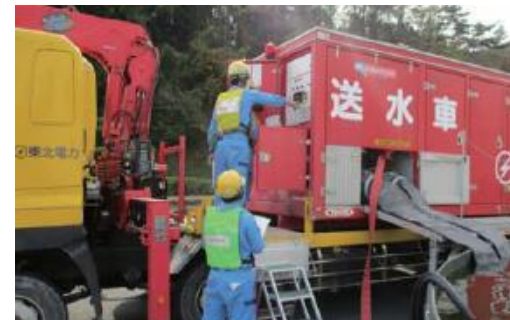
送水車で水をくみ上げる訓練
