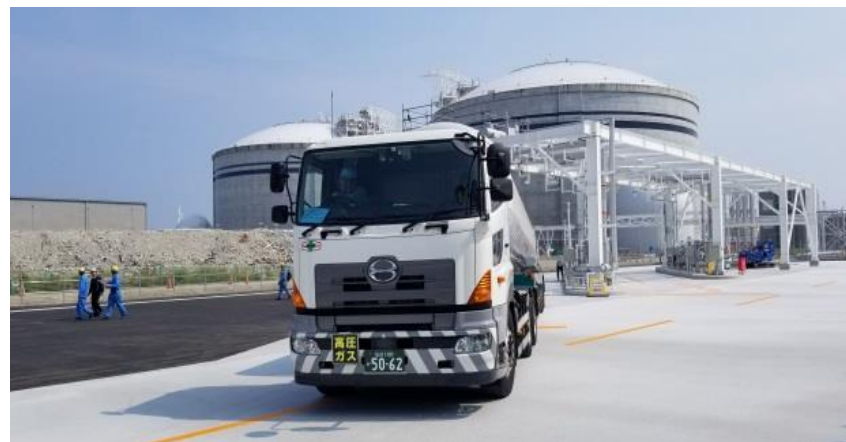
新仙台火力発電所 L N G 出荷設備
