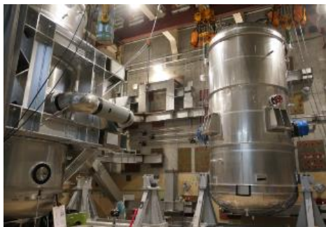
フィルタバント系の設置作業（女川）
