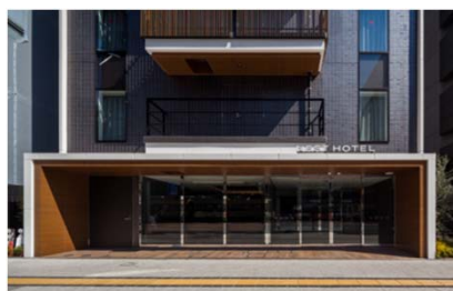
ネストホテル広島八丁堀 (外観)
