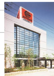
旧本社ビル（加古川市）
