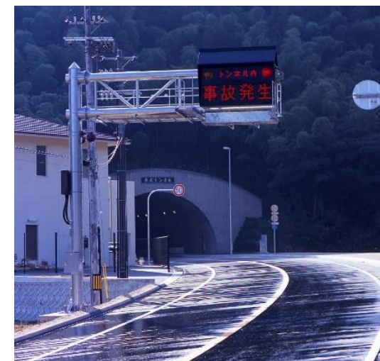
トンネル警報表示板
