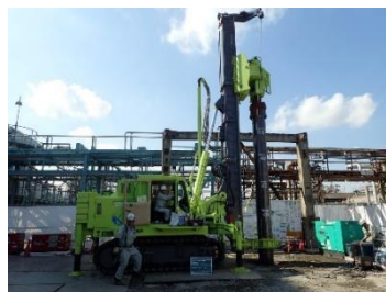
トヨーカネツビルテック社 鋼管杭工事
