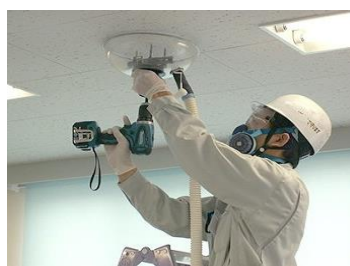
環境リサーチ社 アスベスト調査・分析
