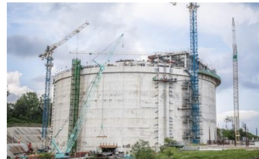
LNGタンク建設
