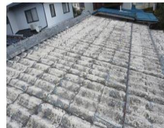
販売後に発覚した屋根材の劣化事例。一部補修が来ず全面的に葺き替えた
