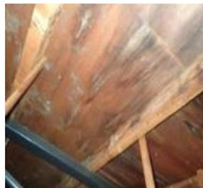
販売後に発生した雨漏りの事例。瑕疵担保責任により全面補修した
