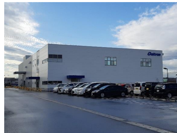
中部第二工場外観
