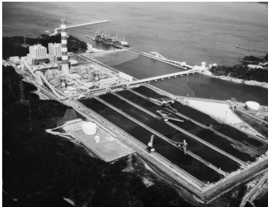
松島火力発電所（1981年運転開始・出力100万kW・長崎県）
