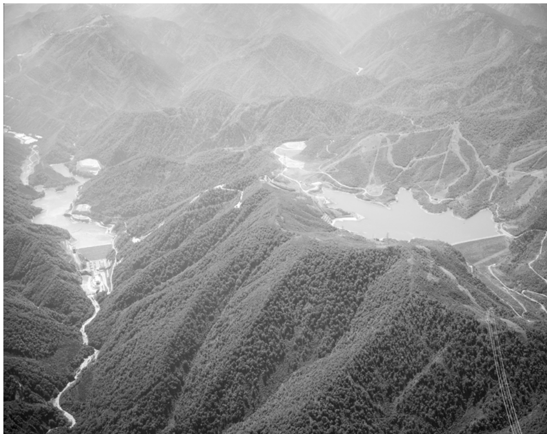
(右)カッサダム・(左)二居ダム・奥清津発電所（1978年運転開始・出力100万kW・新潟県）
