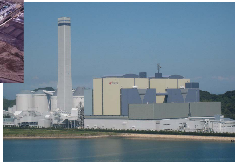
橘湾火力発電所（2000年運転開始・出力210万kW・徳島県）
