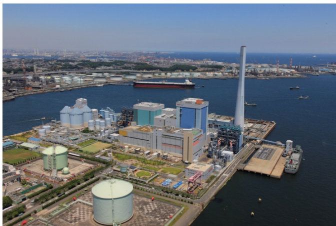
世界最高水準の熱効率を有する礪子火力発電所 (2002年運転開始・出力120万kW・神奈川県)
