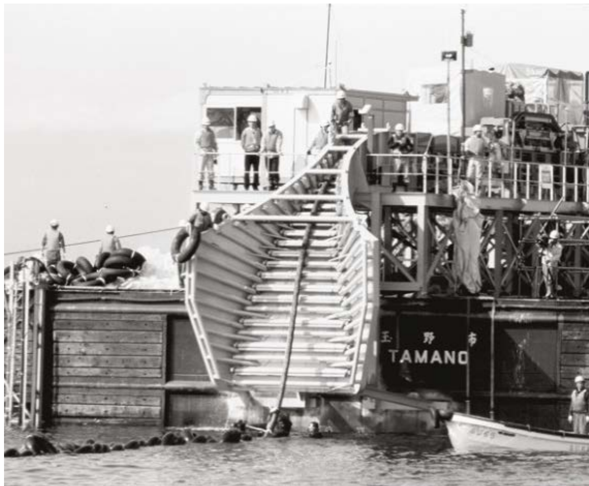
北海道と本州を接続する北本連系設備（1979年運転開始・送電容量60万kW） 海底ケーブル敷設時の様子
