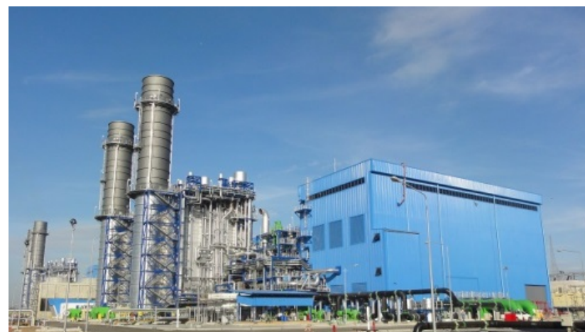
ウタイガス火力発電所 (2015年運転開始・出力160万kW・タイ)
