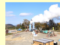
建設中の山葵沢地熱発電所
