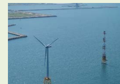
実証試験中の洋上風力設備
