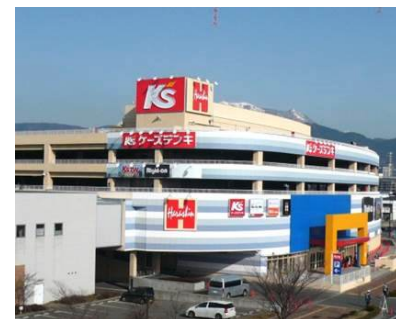
長野商業施設
