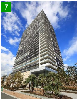
Brillia 有明 City Tower (2015年竣工)
