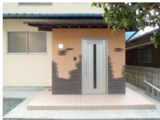
ポーチのタイルを貼りかえ、玄関ドアも新品に交換し、外壁にアクセントタイルを張附(高知県)
