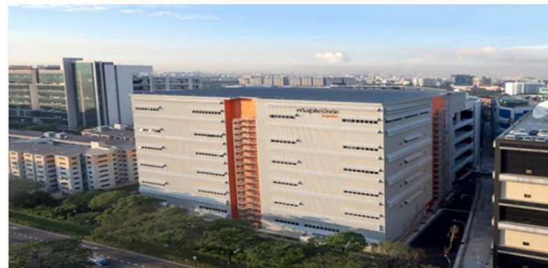
タダノ・シンガポールパーツセンター が入居する建物
