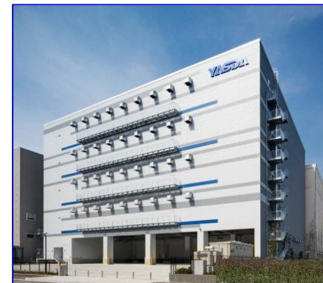
平和島営業所 第二倉庫
