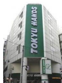
ヒューリック 渋谷宇田川町ビル
