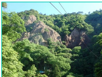
芋川谷山腹工事 （法面保護工事）
