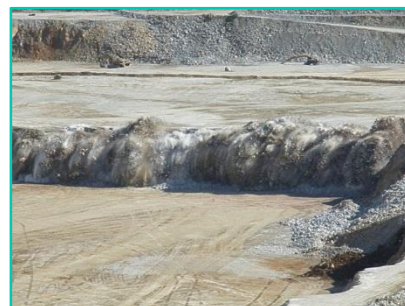
東谷鉾山石灰石採掘工事 （爆砕工事）
