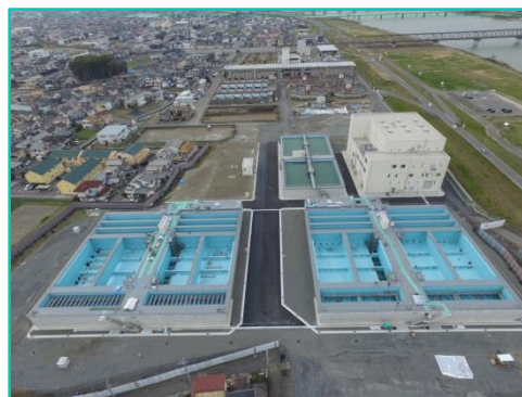
加納浄水場凝集沈殿池築造工事
