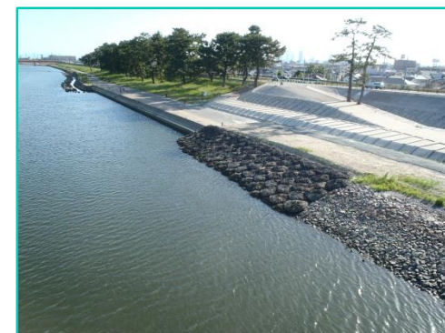
庄内川下之一色しゅんせつ工事
