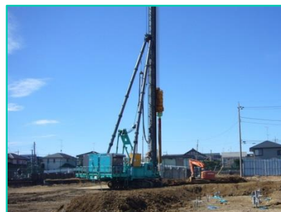
東松山土壌改良工事 （地盤改良工事）
