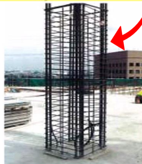
高強度せん断補強筋 施工例
