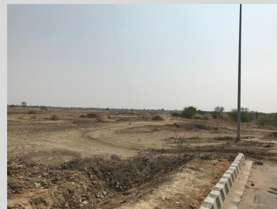
プレス工場建設予定地
