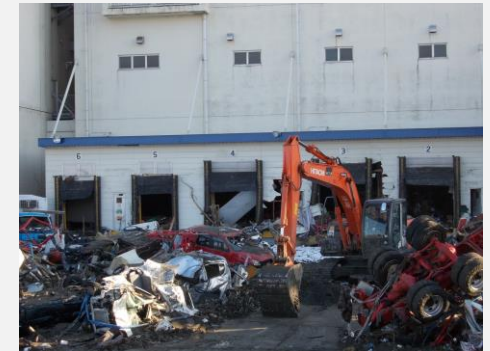
2011年 東日本大震災(仙台物流センター)
