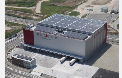
最新鋭の冷蔵倉庫 (夢洲物流センター)
