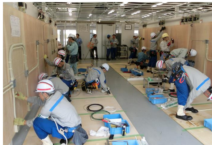
電気配線研修
