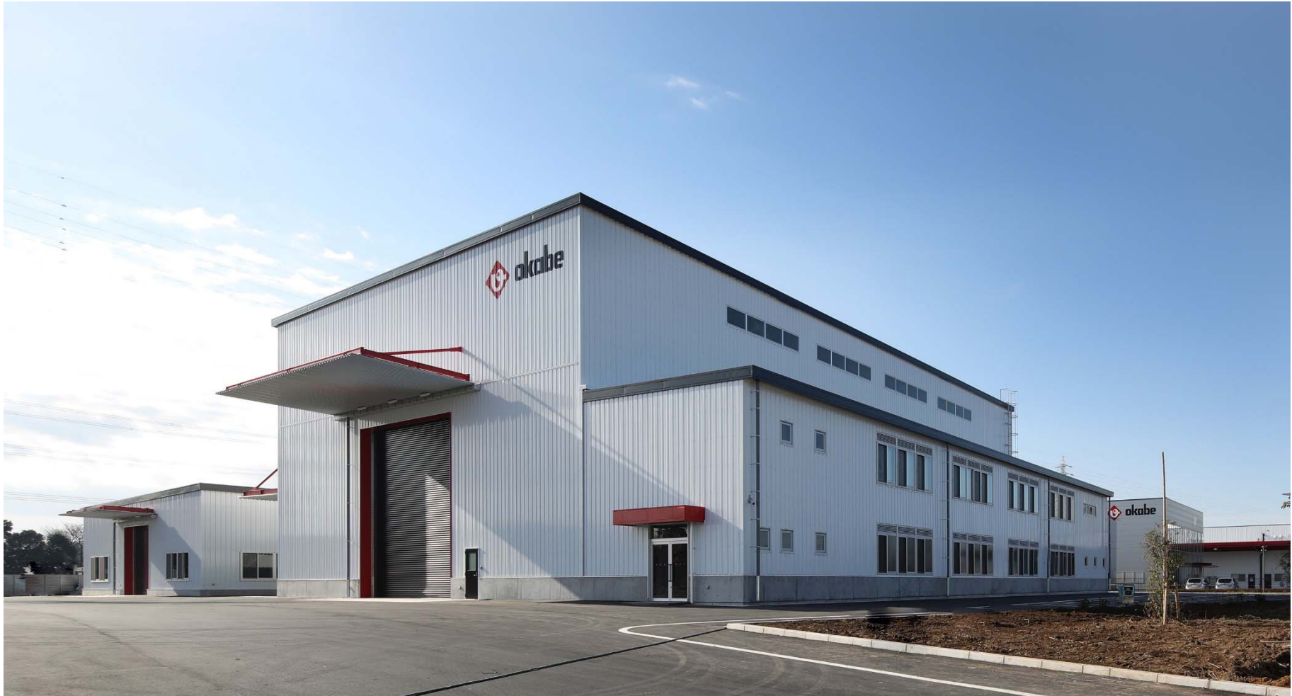
総合実験センター（2017年12月15日竣工）
