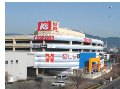
長野商業施設
