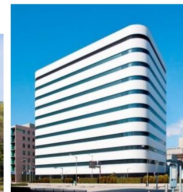
西心斎橋ビル
