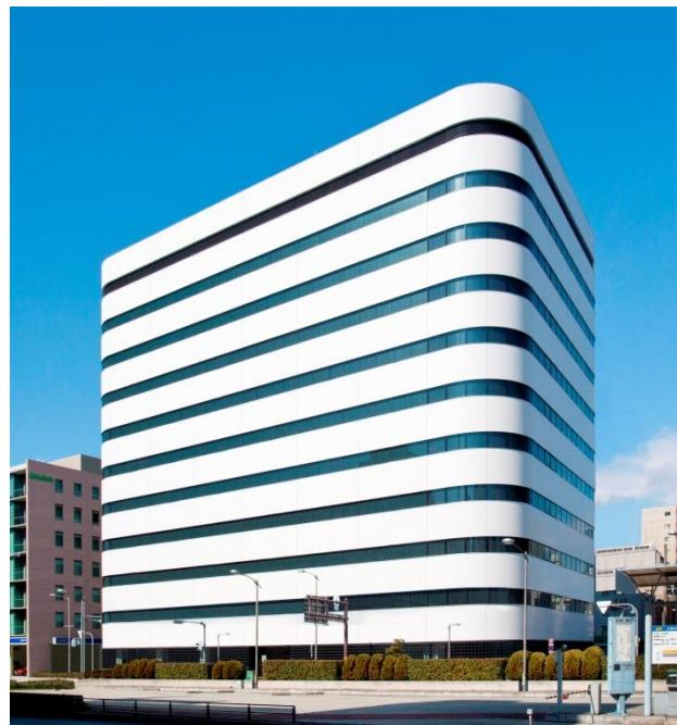
西心斎橋ビル
