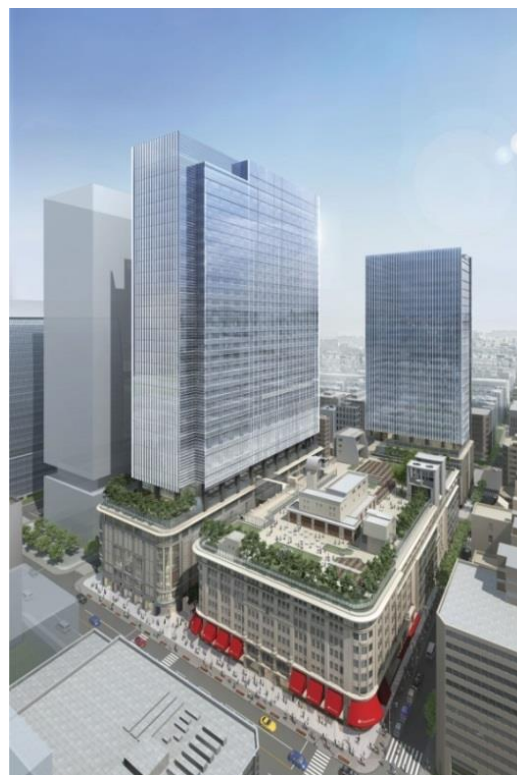
日本橋二丁目再開発PJ (会員制サロン)
