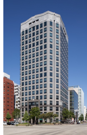
KDX桜通ビル 名古屋市中区丸の内三丁目20番17号
