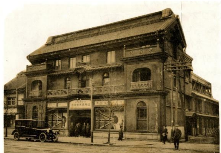
津村順天堂本店（創業当時） 東京都中央区日本橋
