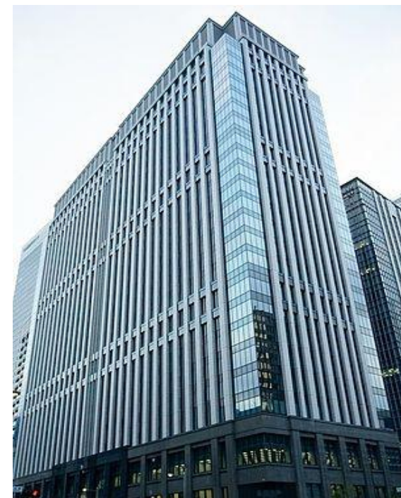
本社（鉄鋼ビルディング）
