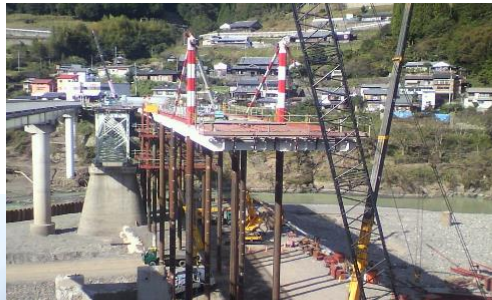
台風災害による緊急災害復旧工事 折立橋仮橋設置:奈良県十津川村 近畿地方整備局 局長表彰受賞
