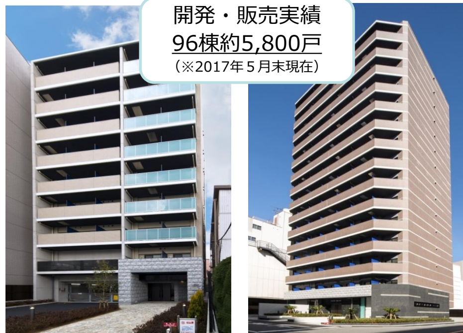
サムティ江坂レガーロ 大阪府吹田市 65戸 2017年2月竣工
