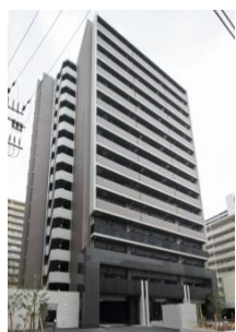
S-RESIDENCE新大阪WEST (大阪市淀川区)
