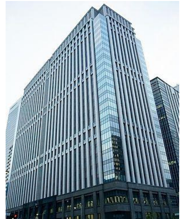
本社（鉄鋼ビルディング）
