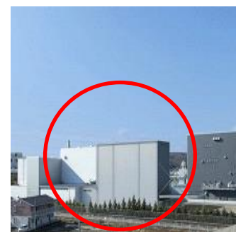
岡山機能糖質工場・T棟
